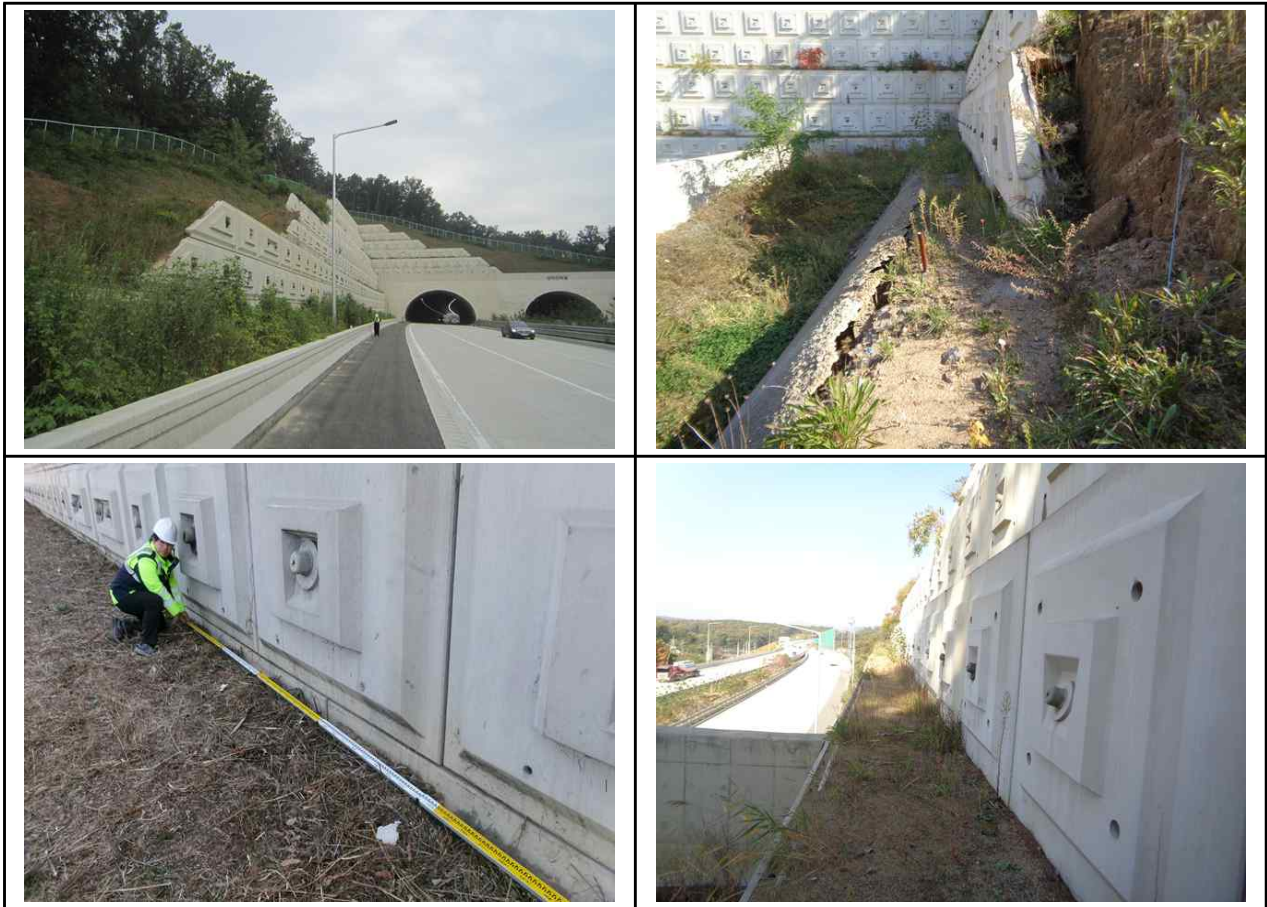
【그림 3.10】 외관조사 전경
