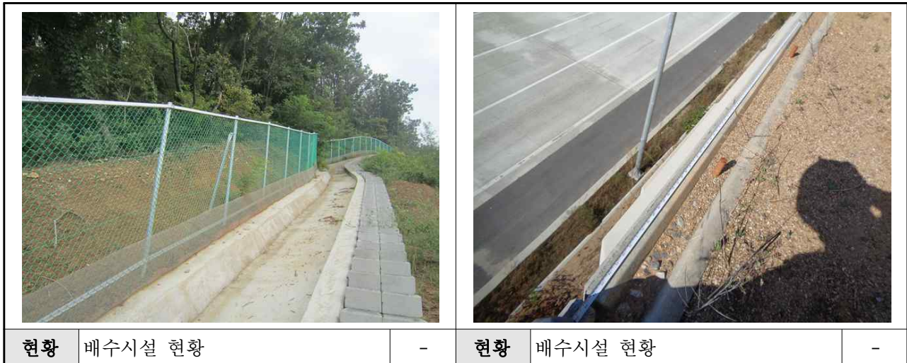
【사진 3.7】 배수시설 현황
