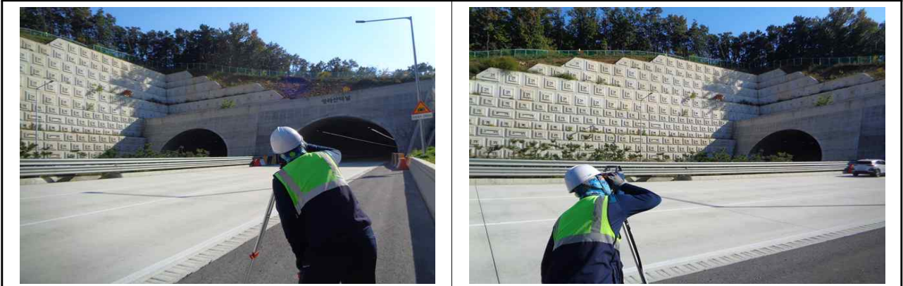
【사진 3.8】 현황측량 전경
