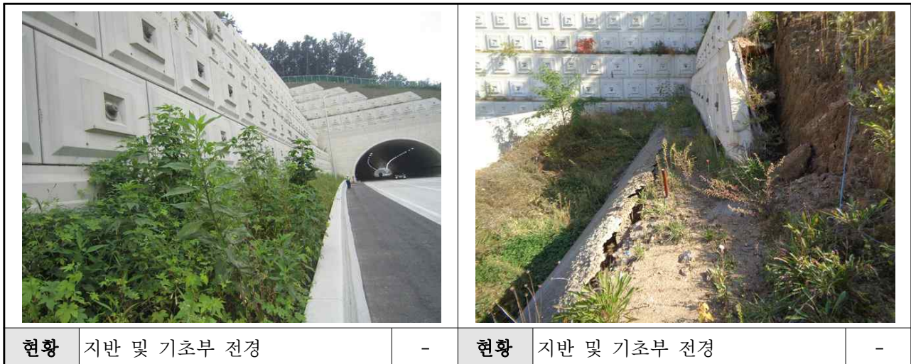
【사진 3.4】 지반 및 기초부 현황
