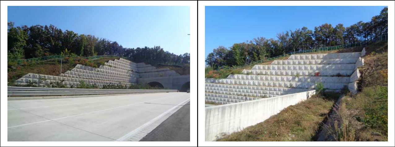
【사진 3.1】 대상옹벽 전경
